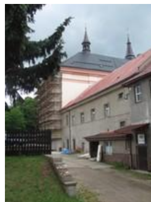
Obr. 2 – Klášterní budova, v zadní části kostel. Klášter byl v průběhu let nevhodně upravován a přistavován. Důležité prostorové prvky však zůstaly a opět mají po odstranění nevhodných přístaveb a vnitřních příček vyzdvihnout architekturu objektu.
