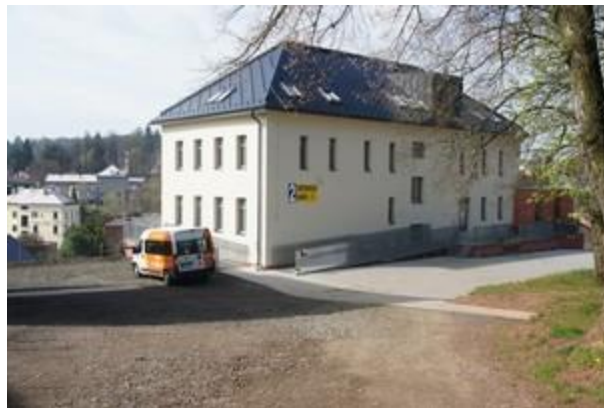
Obr. 5 – Již zrekonstruovaná budova č. 2
