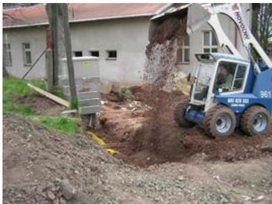
Obr. 3 – Tělesně postižený buduje přípojku plynu
